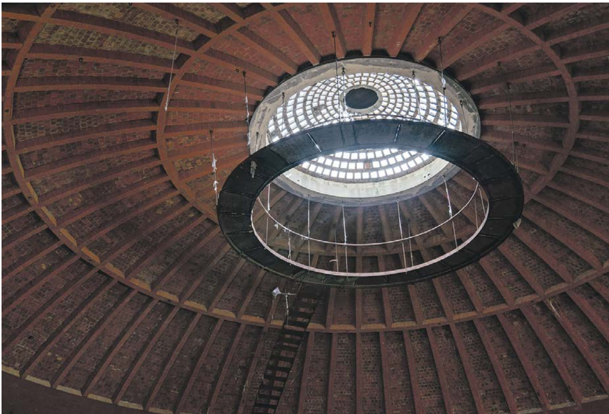
Es gäbe viel zu restaurieren: Einer der zahlreichen Kuppelbauten der Kunstschule.
